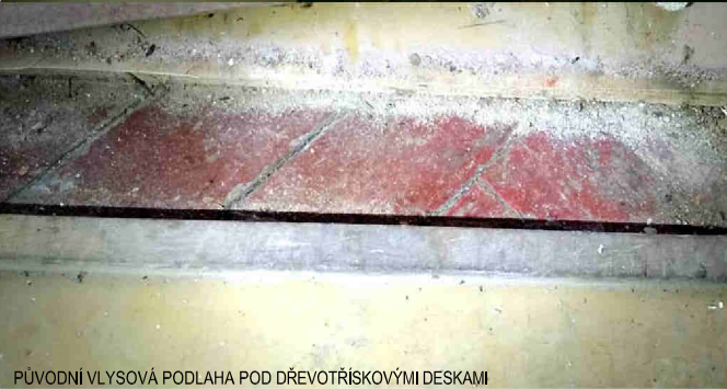
PŮVODNÍ VLYSOVÁ PODLAHA POD DŘEVOTŘÍSKOVÝMI DESKAMI
